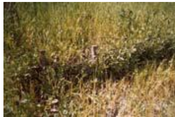
Viminata viva con talee di Salix spp e piantine radicate a monte
