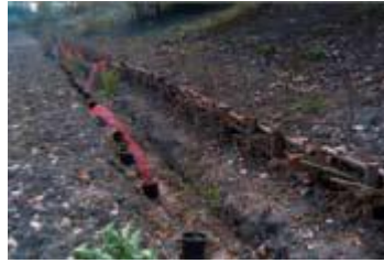
Palizzata viva con talee di Salix spp. e piantine inserite a monte
