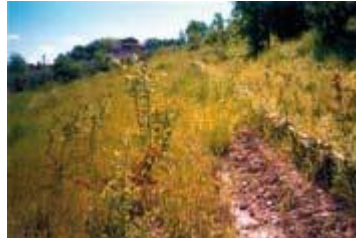
Versante sistemato con opere di Ingegneria Naturalistica ad un anno dall'ultimazione dei lavori
