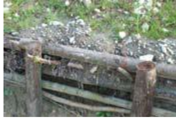
Particolare delle talee di Salix spp. inserite all'interno di una palizzata viva
